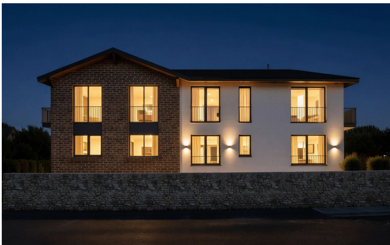
VISTE ESTERNE DELL'EDIFICIO
